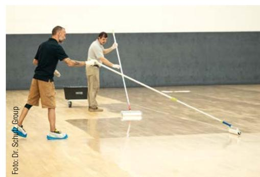
Unmittelbar nach der Trocknung ging es an den Oberflächenschutz mit dem sportbodengeprüften 2K-Wasserlack Eukula Perform 462.
